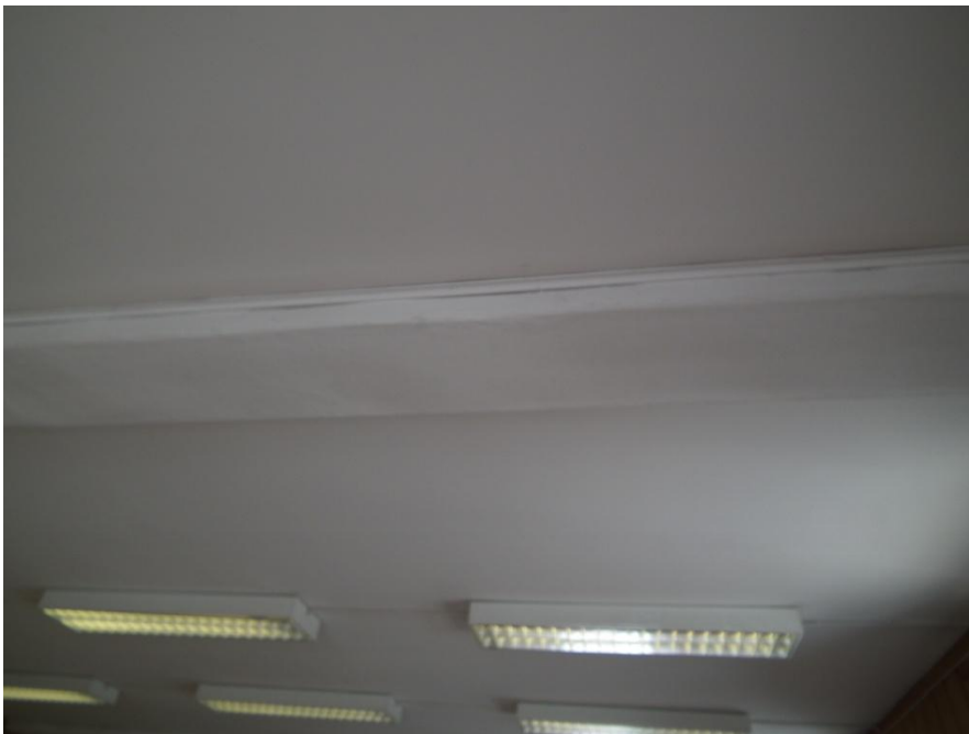
Detalj: Betongdragere i taket
