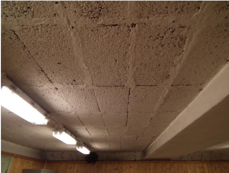
Detalj: Lecablokker og betongbjelker i tak
